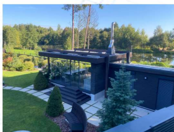
Коттедж Ясная поляна | ALT W72 HS, ALT F50, SL160, ALT111
